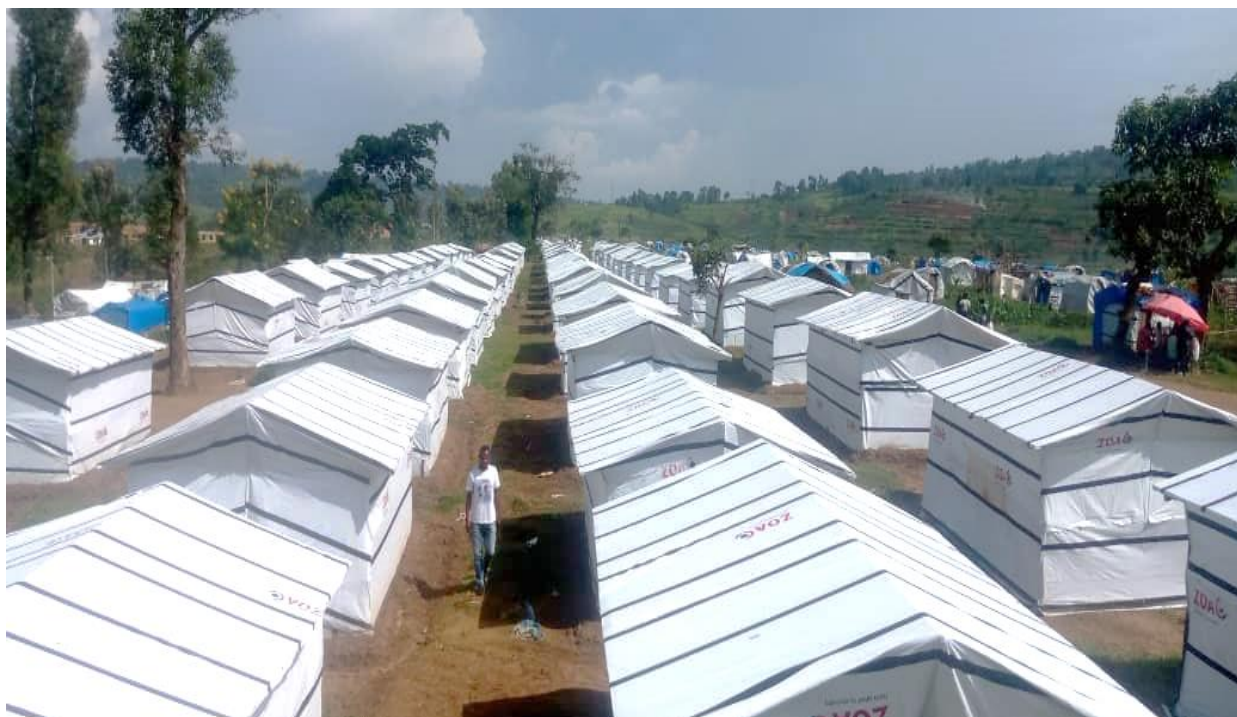
Photo APEDC-RDC: Vue sur plan des abris construits en faveur des ménages déplacés au site Katashola, Avril 2024.
