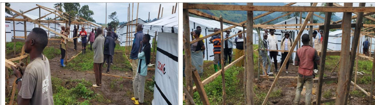
Photo APEDC-RDC : Vue des travaux d’implantation des abris et couverture des murs par les bâches au niveau du site par les artisans locaux et les aides.
