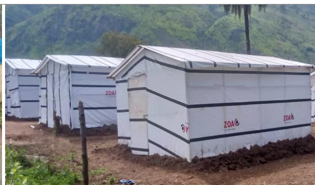
Photo APEDC-RDC: Abri d’urgence types implantés, construits et finalisés dans le site Katashola en faveur des ménages sinistrés.
